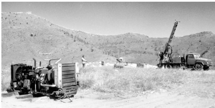
图1 勘探所利用空气反循环钻探技术承担加拿大明科公司在唐山金矿勘探施工现场
