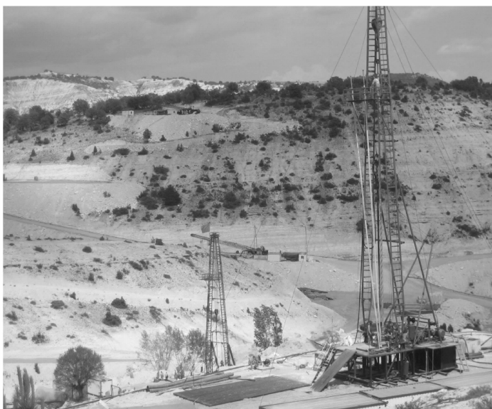
图3 土耳其天然碱矿对接井施工现场
