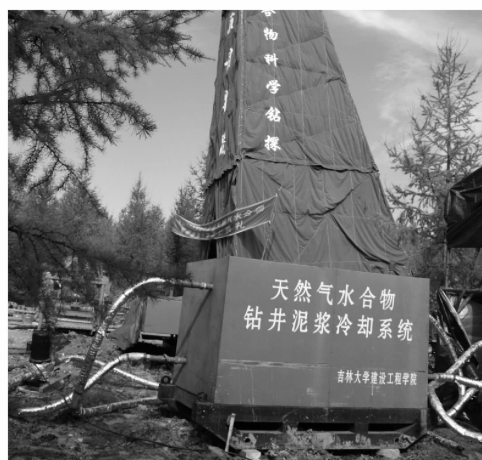
图 4 系统应用于漠河盆地冻土区天然气水合物科学钻探工程
