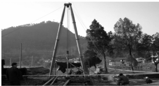
图6 贵州抗旱打井扶贫项目中空式反循环 气动潜孔锤施工现场
