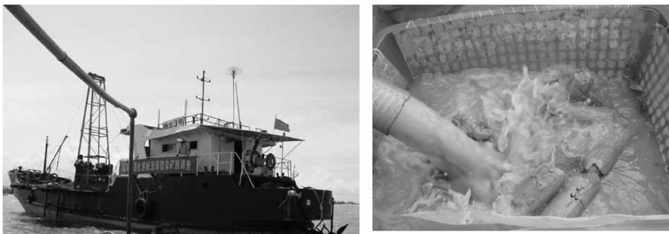
图2 海南感城近海铅钛砂矿水力反循环施工现场及取出的岩心
