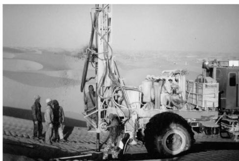
图2 反循环物探爆破孔施工技术在新疆施工现场
