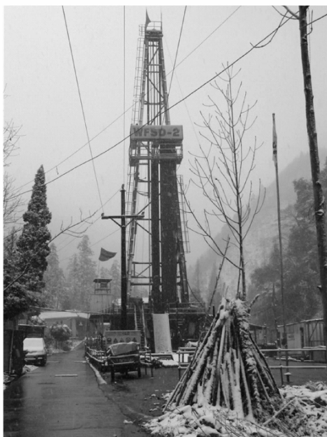
图1 汶川地震科钻孔2号孔现场
