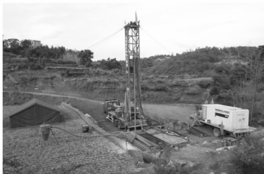
图7 北京军区给水团云南中空式反循环 气动潜孔锤施工现场
