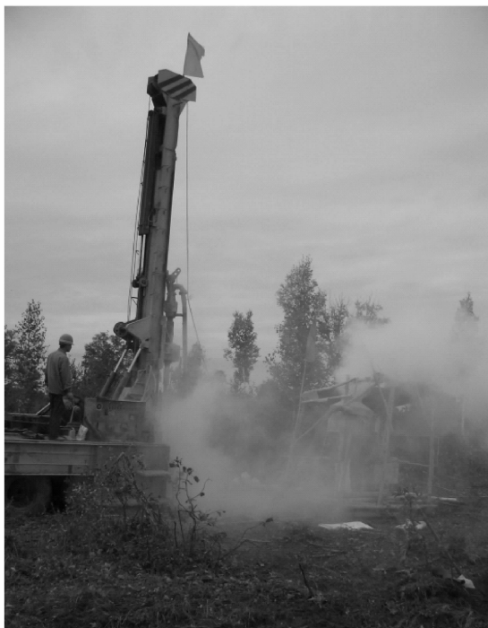
图3 反循环钻探技术在黑龙江加拿大瑞翔公司小兴安岭金矿勘探施工现场
