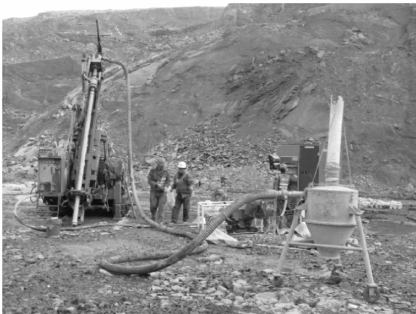
图4 云南砂金勘探反循环连续取样钻进施工现场
