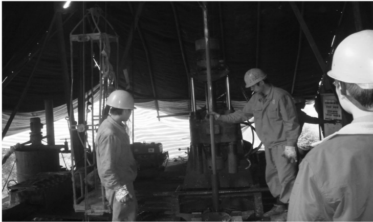
图 1 云南宣威煤田勘探孔（ZK203 孔、ZK101 孔）定向造斜取心施工现场
