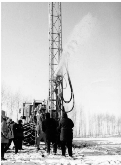
图3 反循环物探爆破孔钻进技术用于东北冬季施工现场
