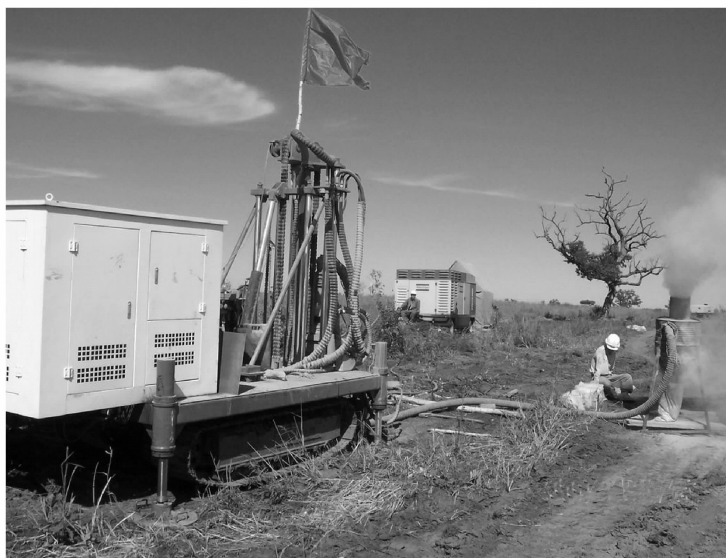
图2 空气反循环钻探在内蒙古赤峰施工现场
