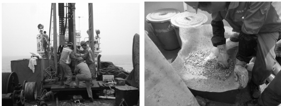
图3 2011年水力反循环钻探在烟台某海域钻探施工现场及取样的海底砂样
