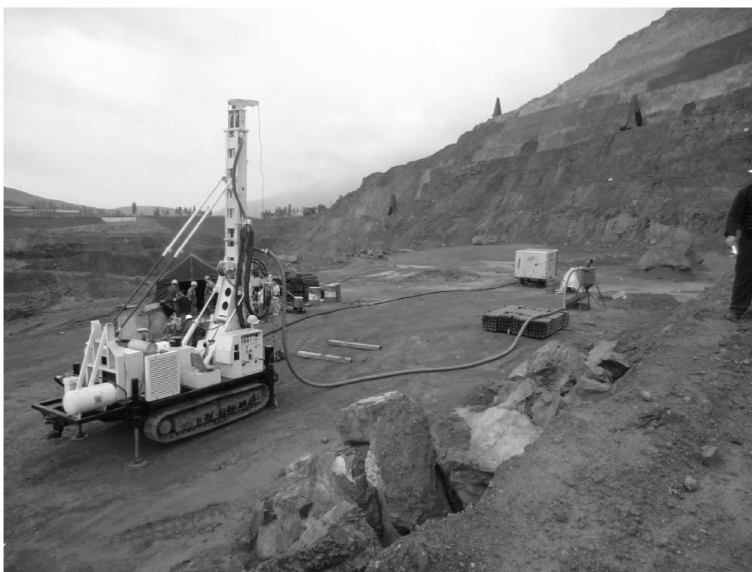
图2 云南大理北衙金矿全孔反循环连续取样钻进现场
